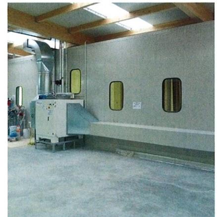
An die Lackierkabine schließt sich ein Trockenkanal an (li.: Bedienpult und Lackpumpen).
