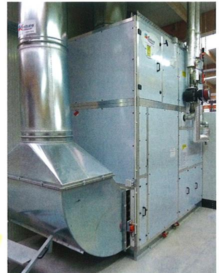
Zur Rückgewinnung der Wärme aus der Kabinenluft ist ein Wärmetauscher installiert.
